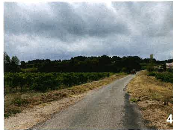
Voie d'accès possible du Sud vers Les Mazes et le centre-ville
