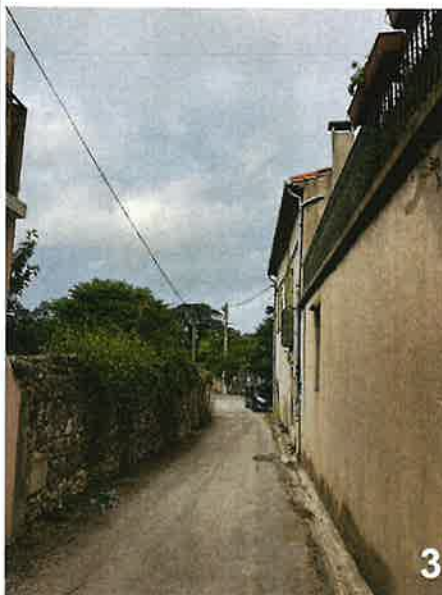
Rue des Lions/Nord de la ZAC - Faible largeur profil voirie
