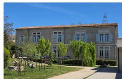
Réfection du toit du Couvent
